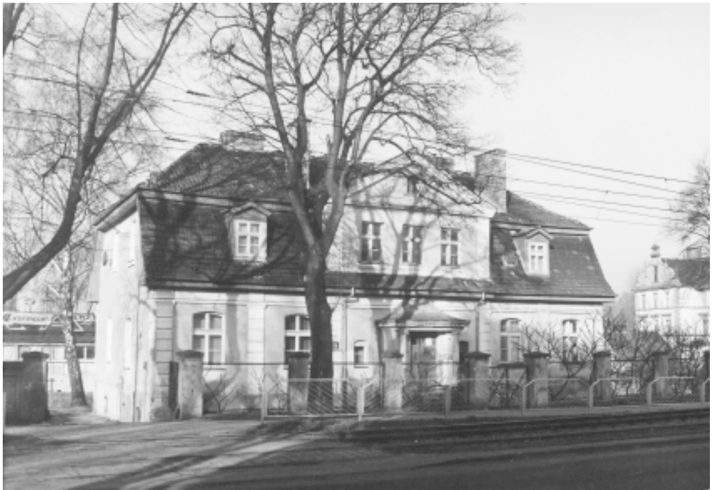
Budynek przy ul. Browarnej 115 w Elblągu, stan z 2003;
